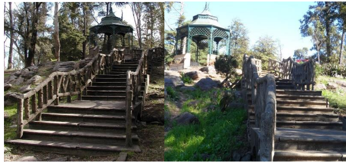
Una pérdida, ¿irreparable?: mirador y baranda faux bois , parque Benito Solari (Salto). Fotos tomadas con dos años de diferencia.
